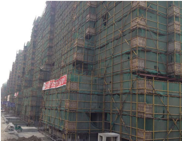
脚手架施工应安装防尘网
