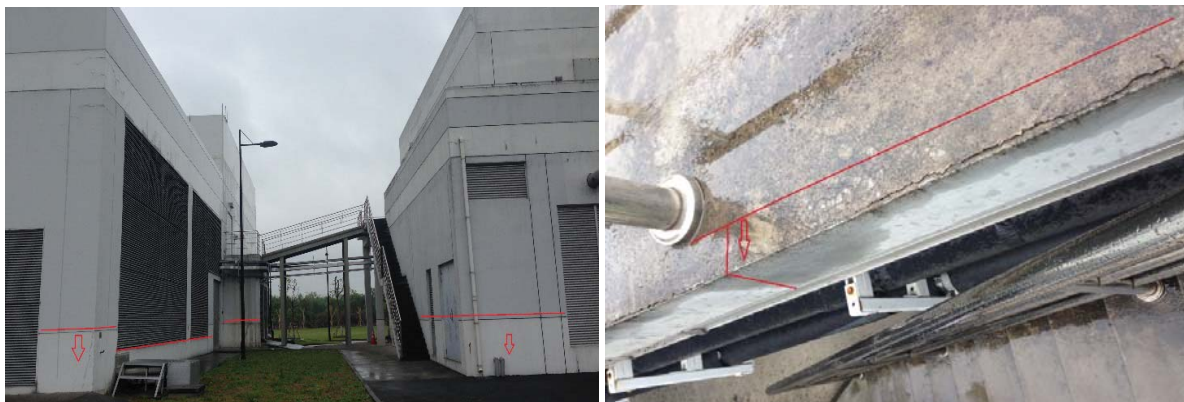
厂房散水墙面【离地面 60cmm 以下墙面】污水处理房人行道栏杆压顶
